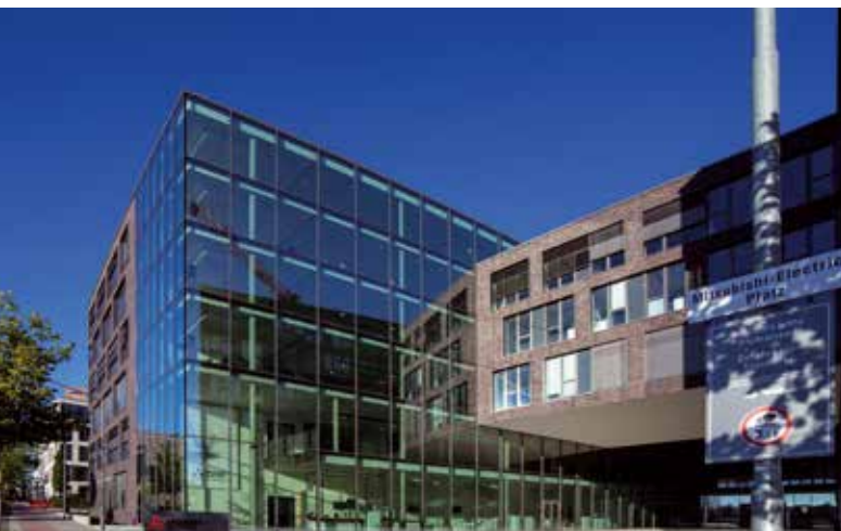
Deutschlandzentrale Mitsubishi Electric, Ratingen
